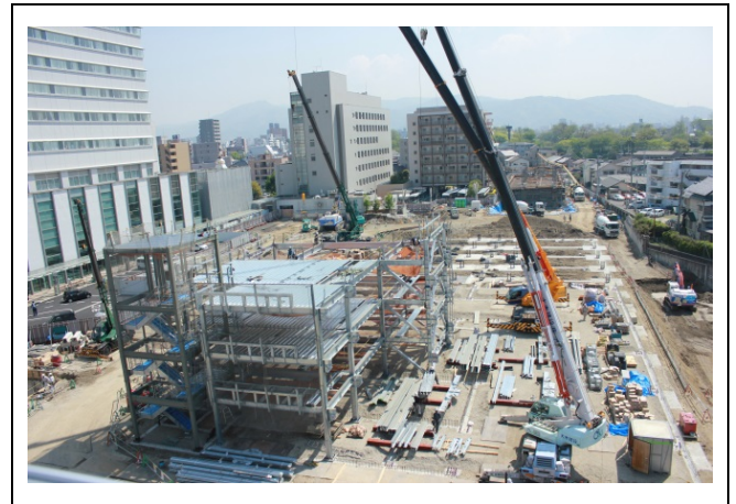
【工事の進む立体駐車場】
